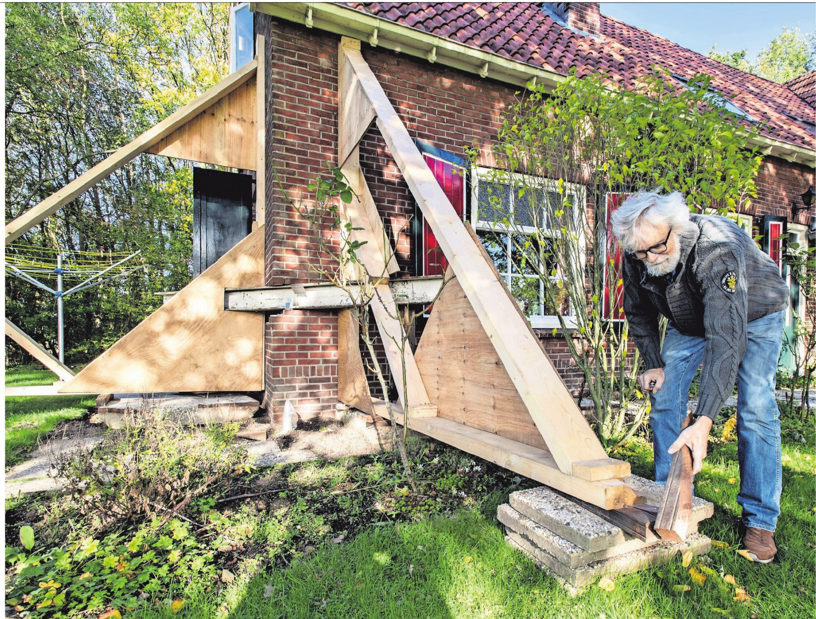
▲ Kees van der Werf tikt een houten wig aan, in de constructie waarmee een hoek wordt gestut van het in 1952 gebouwde voorhuis van de boerderij. FOTO FRANS NIKKELS
